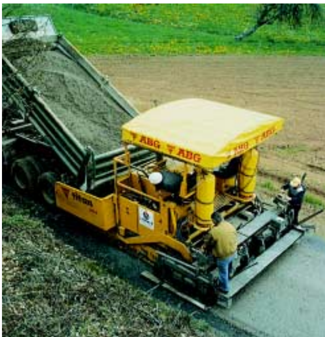
Bild 8: Einbau einer HGTD mit einem Straßenfertiger
