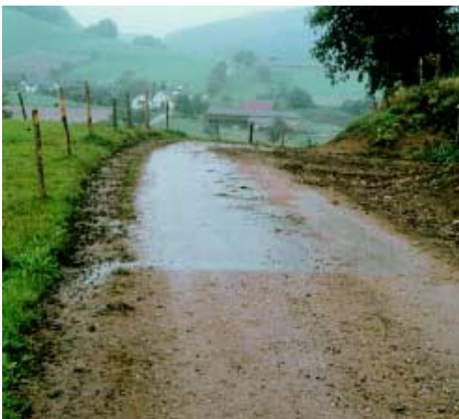
Bild 7: Nasser Asphalt, daneben Trampelpfad der Kühe, vorne Regenwasser haltende, hydraulisch gebundene Tragdeckschicht
