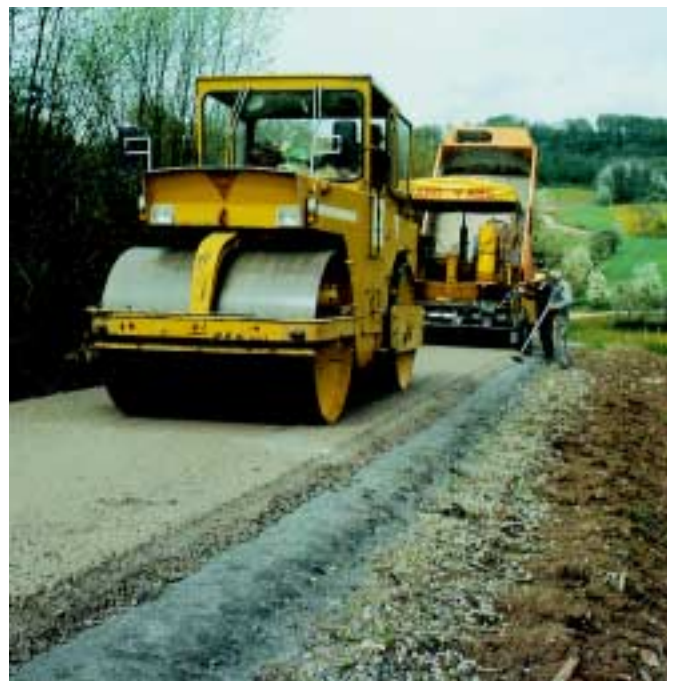
Bild 9: Walzen einer HGTD
