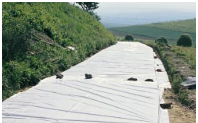
Bild 8: Nachbehandlung der Betondecke durch Abdecken mit Folien
