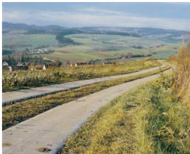
Bild 9: Spurweg mit Betonspuren aus Ortbeton
