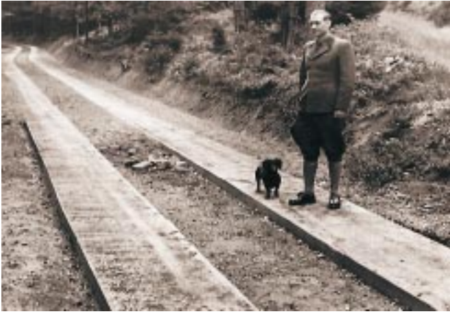
Bild 10: Spurwegebau vor 50 Jahren
