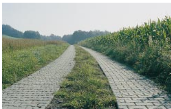
Bild 15: Spurweg aus Betonpflastersteinen mit Verbund
