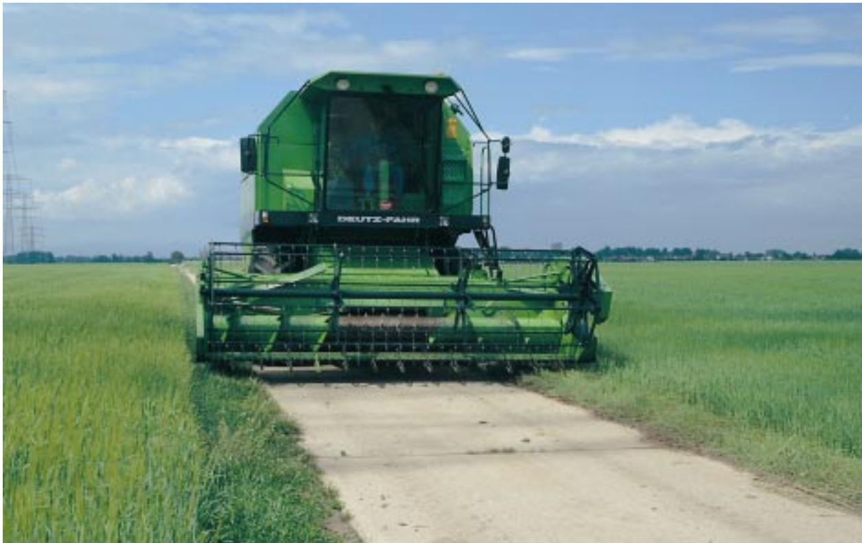
Bild 1: Wirtschaftsweg mit Betondecke
