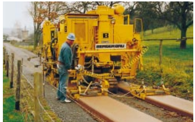
Bild 13: Einbau von Betonspuren mit einem Gleitschalungsfertiger
