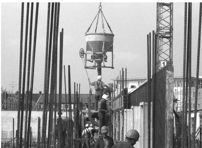
Bild 3: Fördern des Betons mit dem Kübel
