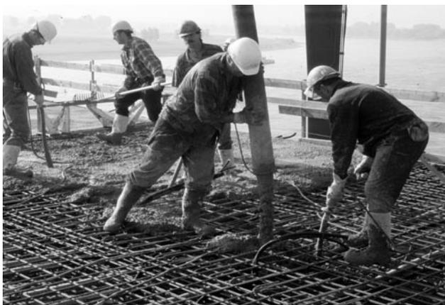
Bild 1: Verarbeiten von Beton auf der Baustelle
