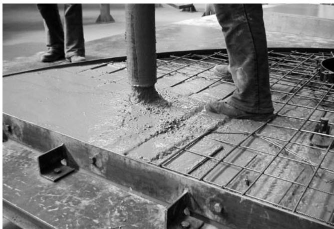
Bild 5: Herstellen eines Deckenelements aus SVB (aus [10])
