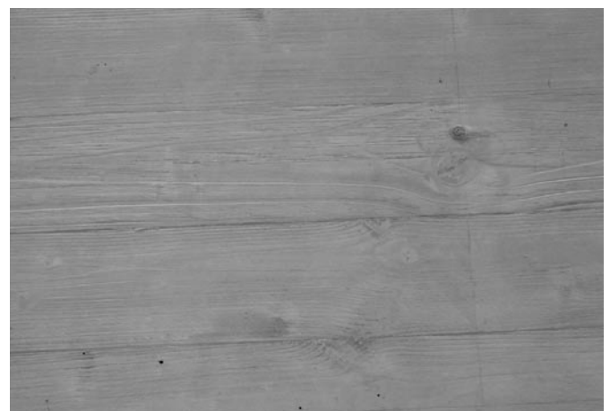
Bild 7: Mit SVB hergestellte Ortbetonwand in Frankfurt (aus [10])
