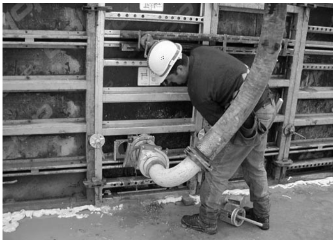
Bild 6: Science Center Wolfsburg: Einpumpen des Betons von unten in die Schalung (Foto: Doka; aus [10])
