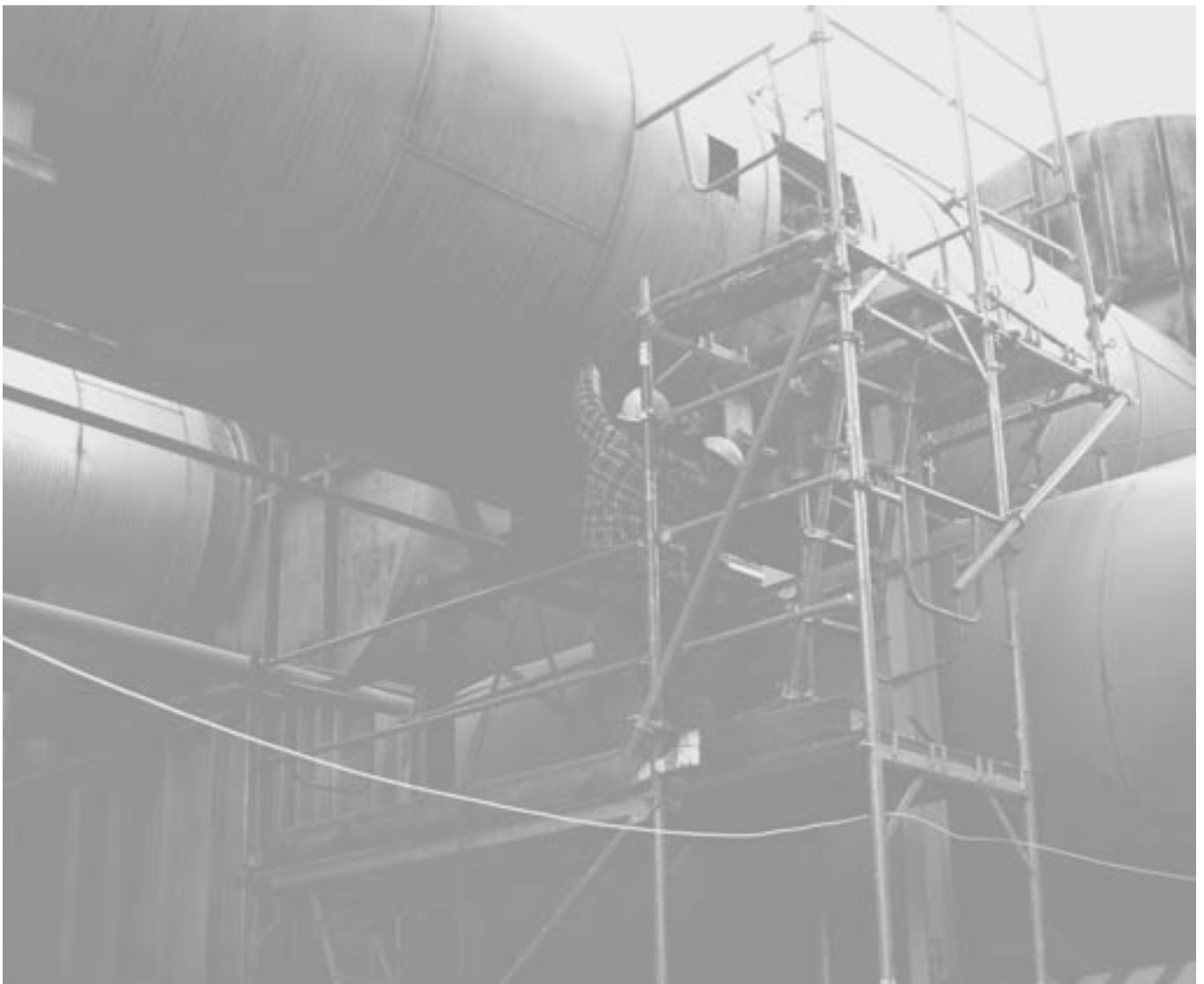
Vorschriftsmäßige Absicherung bei Wartungsarbeiten
