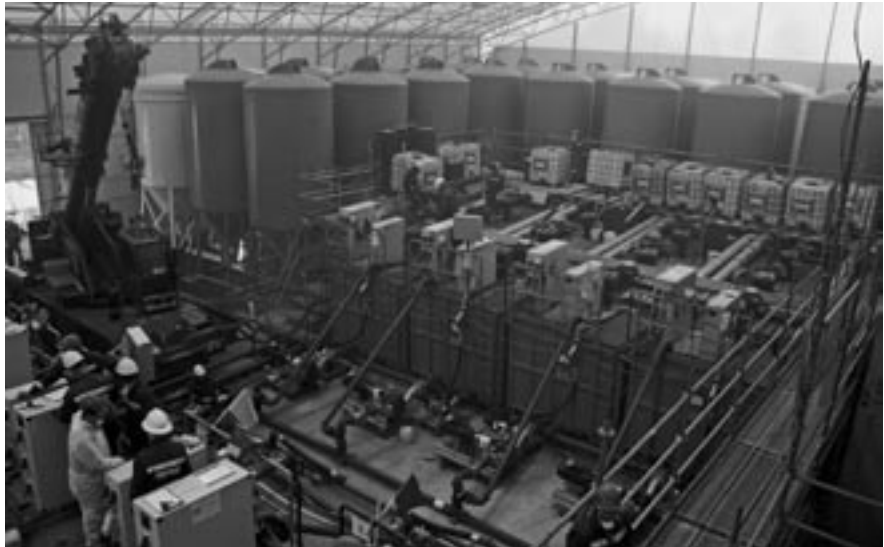
Bild V-45: Blick auf vier von acht Anmischttanks, einen Teil der Silos mit Ausgangsstoffen und den mobilen Kran im Inneren des Baustellenzelts während der Verfüllung des Reaktorbehälters
