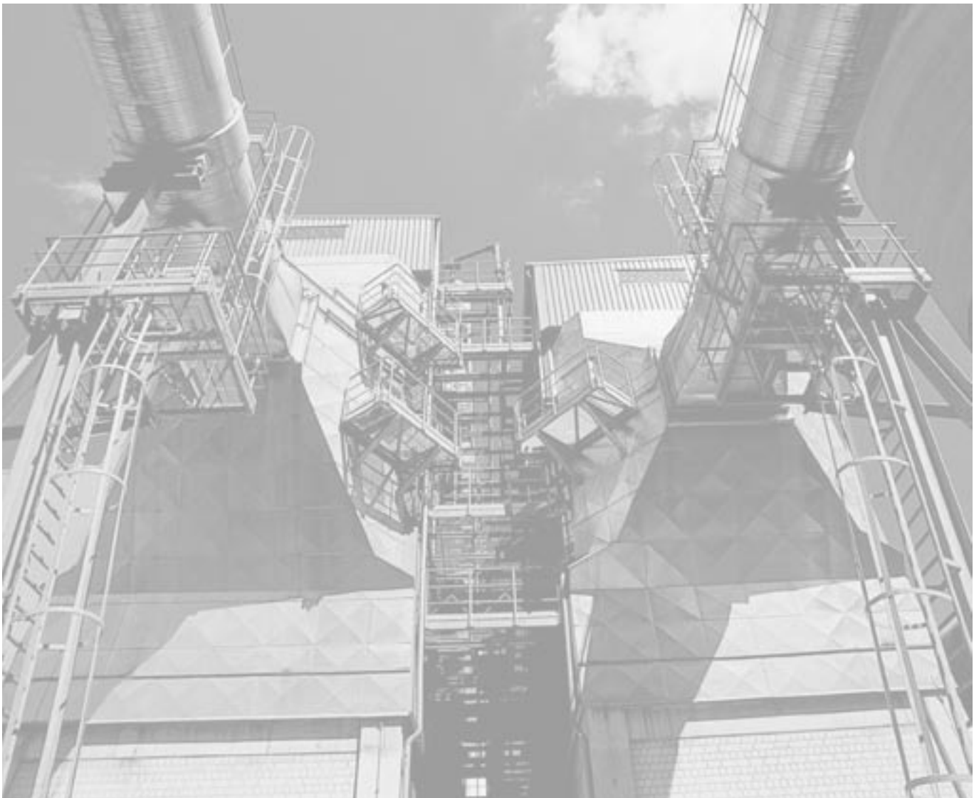
Teile der Abgasreinigung eines Klinkerofens
