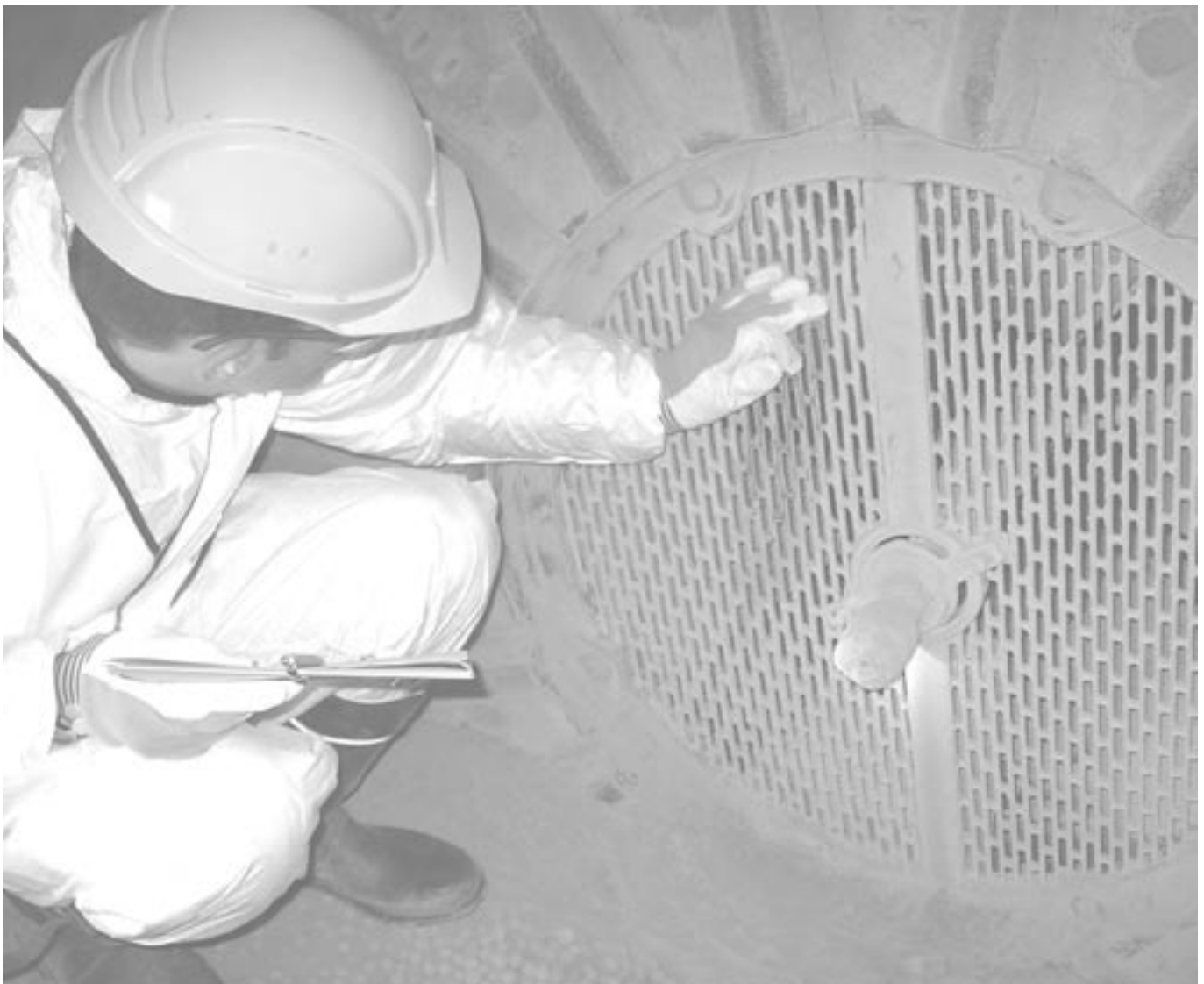
Kontrolle der Austragswand einer Kugelmühle
