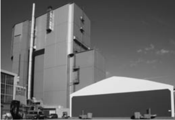
Bild V-44: AVR-Versuchs- reaktor mit Material- schleuse (links) und Baustel- lenzelt zur Verfüllung des Reaktorbehäl- ters (rechts)
