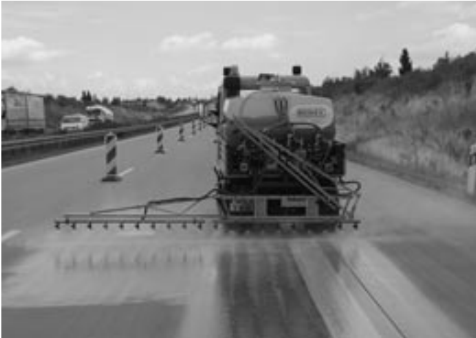
Bild V-39: Tränkung der Betonfahrbahndecke mit Leinölfirnis
