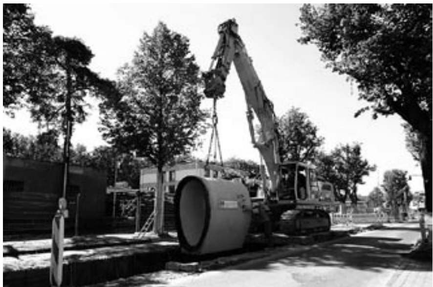
Bild V-61: Verlegung von Betonrohren für den Abwasserbereich
