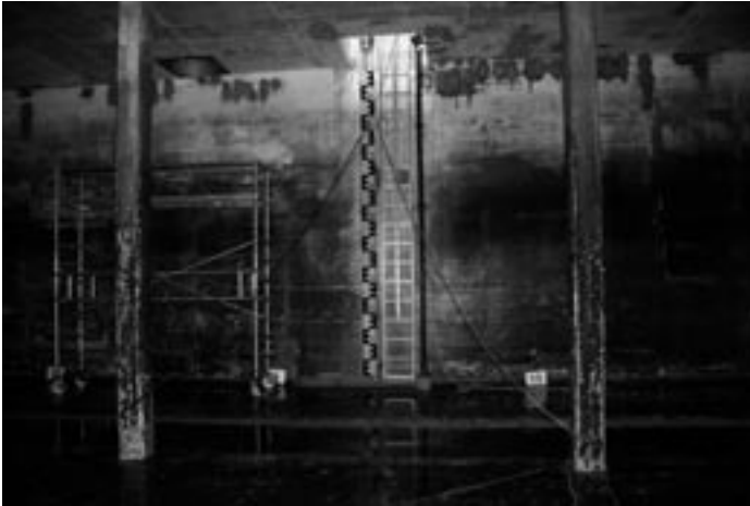
Bild V-62: Bauzustands- analyse eines Trinkwasser- behälters
