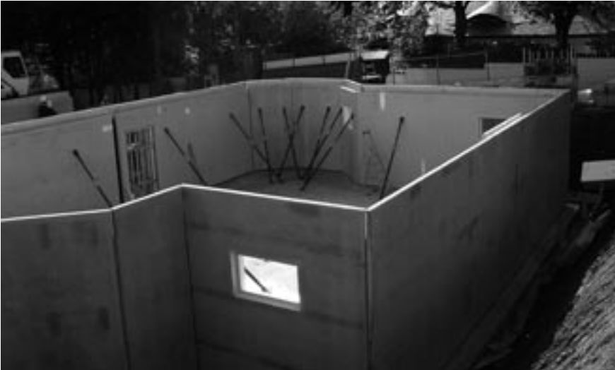
Bild V-59: Errichtung einer „Weißer Wanne“ (Wasserundurchlässiger Beton)
