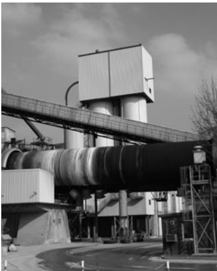
Bild I-15: Silos zur Umlaufhomogenisierung für Bypassstaub
