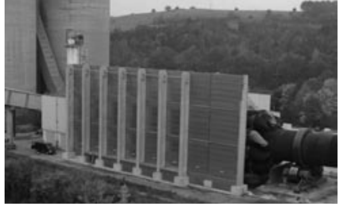
Bild II-27: Situation nach Errichtung des Schallschirms
