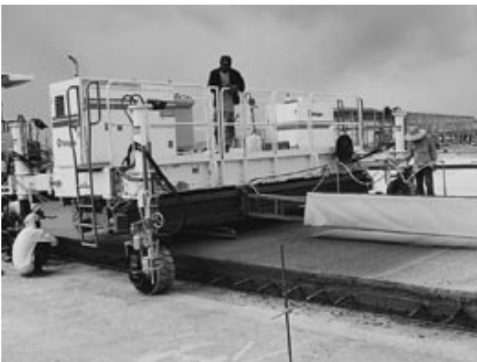
Bild V-34: Aufsprühen des Nachbehand- lungsmittels durch selbstfah- rendes Gerät
