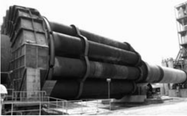
Bild II-26: Situation vor Errichtung des Schallschirms
