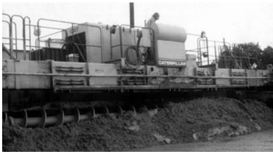
Bild V-19: Einbau mit dem Gleitschalungsfertiger: Eintrag von Mischenergie in den Frischbeton durch die Verteilerschnecke
