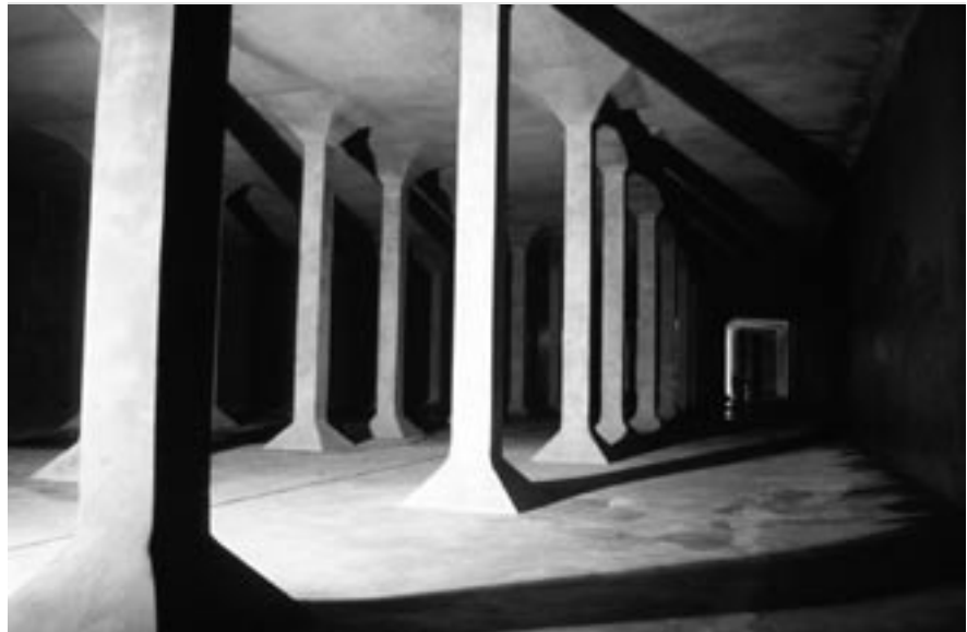
Bild V-60: Trinkwasserbehälter nach Instandsetzung
