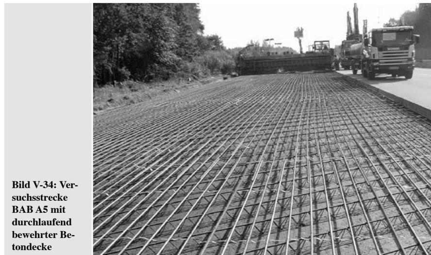
**Bild V-34: Versuchsstrecke BAB A5 mit durchlaufend bewehrter Betondecke**
