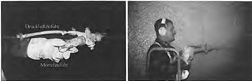
**Bild 1-2:** Dokumentation des Nassspritzverfahrens im Dichtstrom: Bei diesem Verfahren wird der fertiggemischte Mörtel über eine Schneckenpumpe in den Schlauch gepresst. Durch die Treibluft wird der Mörtel an der Düse aufgerissen (links) und an die Wand gespritzt (rechts). Die Oberfläche zeigt bei diesem Verfahren eine Hammerschlagstruktur mit kleinen eingeschlossenen Luftporen, deren Durchmesser rd. 1 bis 2 mm beträgt.
