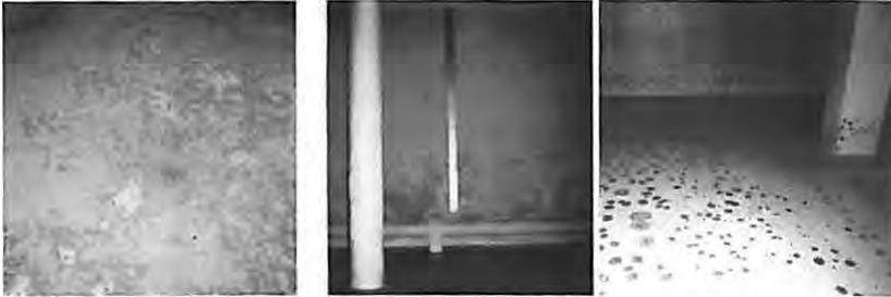
**Bild 1-3:** Unterschiedliche Ausprägung der Schadensform an Behälterbeschichtungen: flächiger Schaden (links) und fleckigenförmige Schäden (mitte und rechts). Alle Bilder zeigten eine von oben nach unten zunehmende Schadensdichte.
