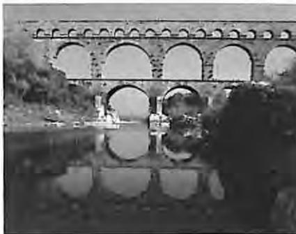
**Bild 2-6:** Pont du Gard bei Nîmes/Frankreich: Römisches Aquädukt aus „Opus Caementitium“, Bindemittel aus gelöschtem Kalk mit natürlichen und künstlichen Puzzolanen. Baubeginn 19 v. Chr. [79].
