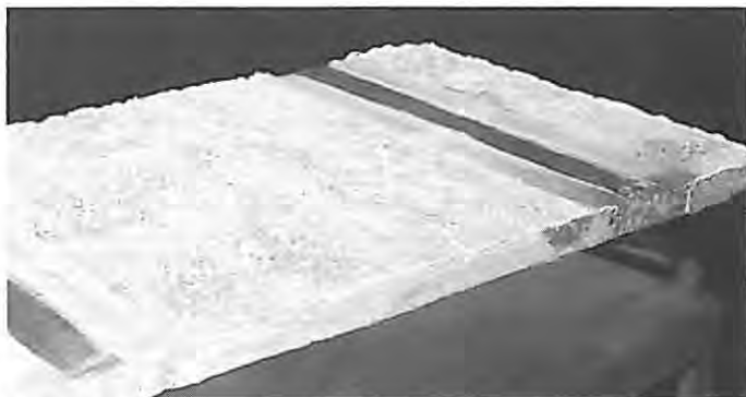
Bild 8 Von der Dämmschicht abgelöste Estrichmörtelschicht
