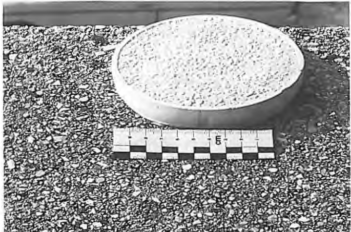
Bild 11 Frei bewitterte Abdeckplatte einer Balkonbrüstung im Alter von 35 Jahren mit einem mittleren Abtrag von rd. 0,3 mm und Abguß zum Vermessen der Rauhtiefe.
