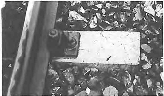
Bild 2 Krakelee-Rißbildung auf der Betonoberfläche am Kopf einer Spannbetonschwelle im Gleis
