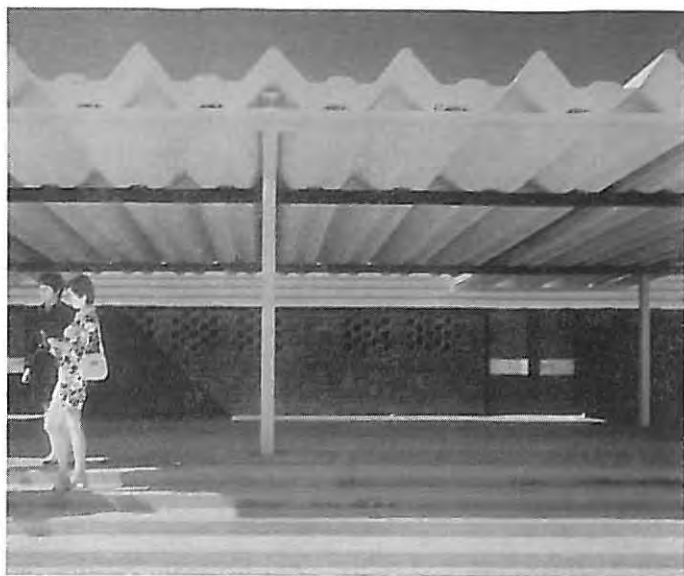
Bild 22 Großformatige Dacheindeckung aus Asbestzement (Werksfoto Eternit AG)
