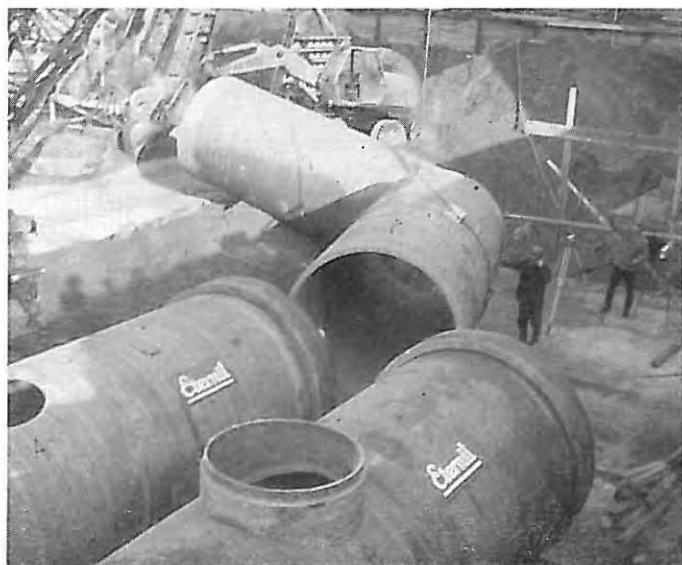
Bild 23 Rohre für eine Druckwasserleitung aus Asbestzement (Werksfoto Eternit AG)
