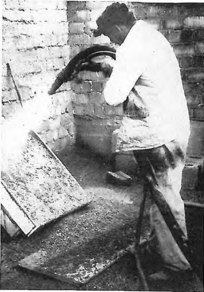
Bild 7 Einspritzen einer Schalungsform
