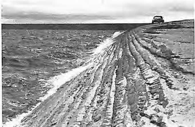
Bild 1 Böschungsschutz durch abgetrepte Lagen einer Boden-Zement-Verfestigung
