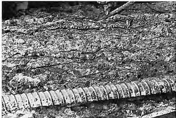
Bild 7 Verstärkte Gefügebrauchung rechtwinklig zur Bewehrung
