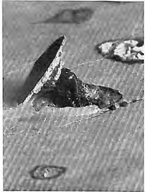
auftreten, sind für den Nichtfachmann allerdings leicht verwechselbar mit Abplatzungen über einem nichtfrostbeständigen Zuschlagkorn. Auch Abplatzungen größerer Betonteile sind möglich, z. B. über etwas tiefer liegenden, größeren reaktionsfähigen Zuschlagkörnern.
