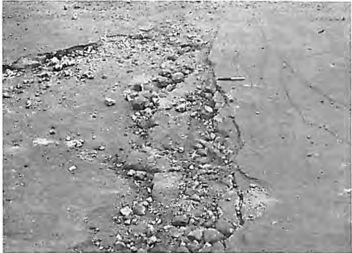
Bild 7 Beschädigung einer Betondecke durch wiederholt austretendes Flüssiggas (Stickstoff) unterhalb einer Abfüllstation
