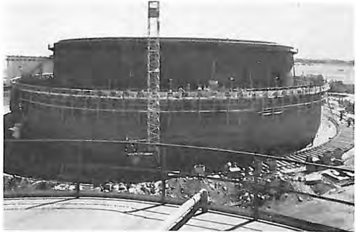
Bild 2 Stahlbetonschutzbehälter um einen Stahlank zur Lagerung von Heizöl während des Baus [4]
