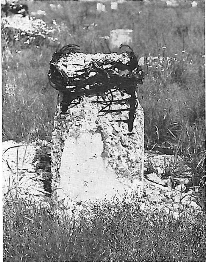
Bild 1 Durch Rammschläge zerstörter Pfahlkopf eines Betonrampfhahles
