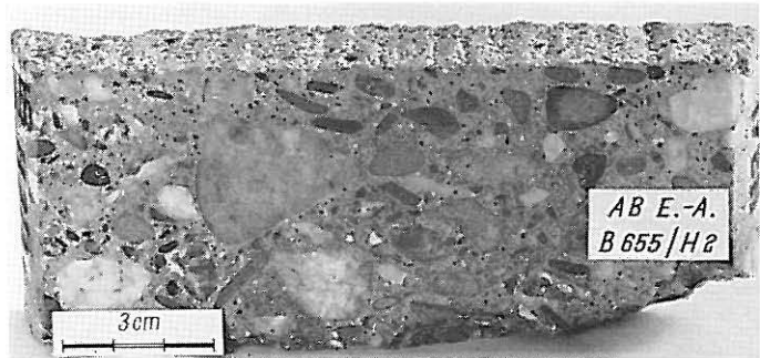
Bild 15 Fahrbahnfläche und Gefüge des Deckenbetons einer Autobahn. 400 kg Zement/m 3 , w = 0,42; 50 % Flußsand 0/7 mm und Kies bis rd. 30 mm. Baujahr 1961, 2½ Jahre unter Verkehr.
