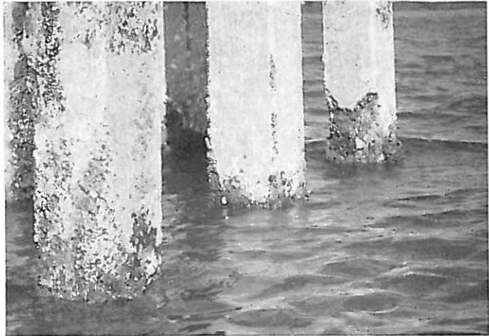
Bild 12 Pfähle bei St. Augustine mit Zement 18 ( C_3A -Gehalt 12,2 %) )
