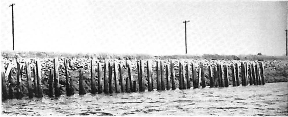
Bild 9 Pfähle bei Cape Cod; Überblick
