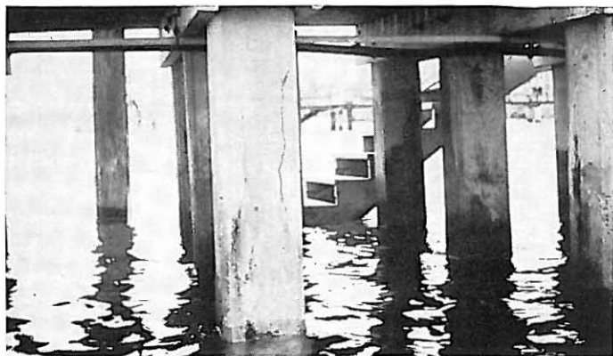
Bild 14 Pfähle bei Newport Beach, die typische Risse über der Bewehrung zeigen
