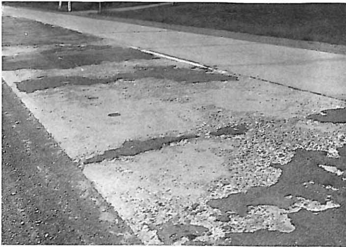
Bild 2 Versuchsstraße New York; Fahrbahn im Vordergrund mit Zement ohne Luftfeinführung, im Hintergrund mit LP-Zement
