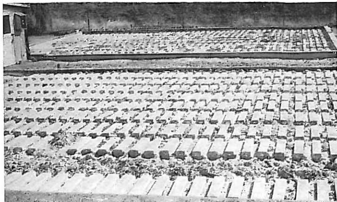
Bild 7 Beton in sulfathaltigem Boden in Sacramento
