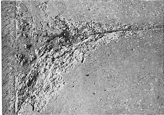
Bild 6 Versuchsstraße Topeka; typische Bildung von D-Rissen und Ausfasern an Ecken und Fugen nach 12 Jahren
