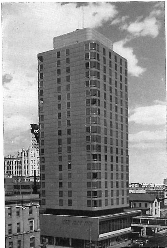
Bild 9 Brown Palace Hotel in Denver. Stützen und Decken aus Konstruktions-Leichtbeton (Stützen B 410, Decken B 310, Rohdichte 1,54 kg/dm 3 [10])
