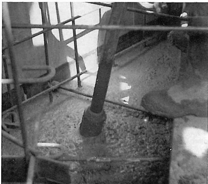
Bild 12 Prebluft-Innenrüttler (Typ NM 70; Fa. Netter)
