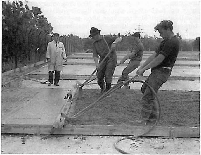
Bild 14 Preßluft-Rüttelbohle (Typ VG 350; Fa. Netter)
