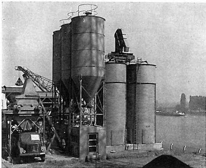
Bild 3 Transportbetonwerk in Mainz, Stundenleistung etwa 60 m<sup>3</sup>. Werkfoto:
