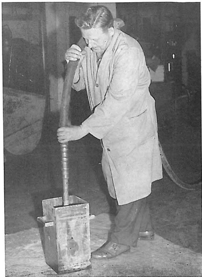
Bild 6 Vollständiges Verdichten des ursprünglich mit losem Beton gefüllten Behälters durch einen mittig eingeführten Innenrüttler (auch durch kräftiges Stampfen möglich)
