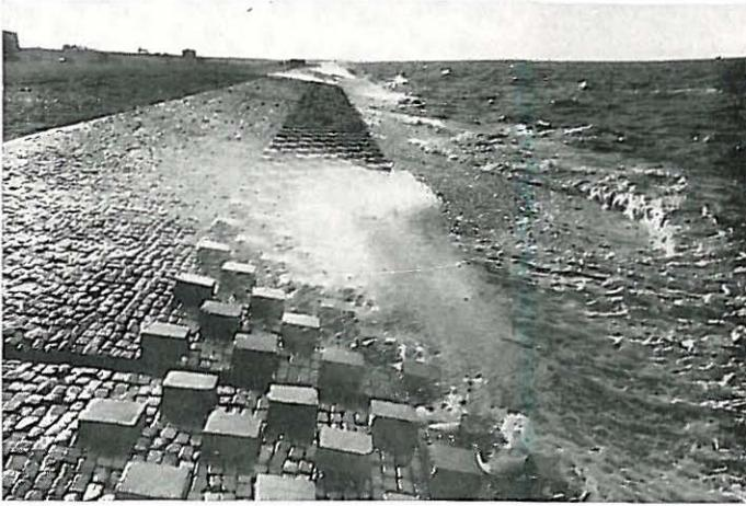
Bild 1 Betonsäulen im Klinkerdeckwerk bei Eckwarderhörne
