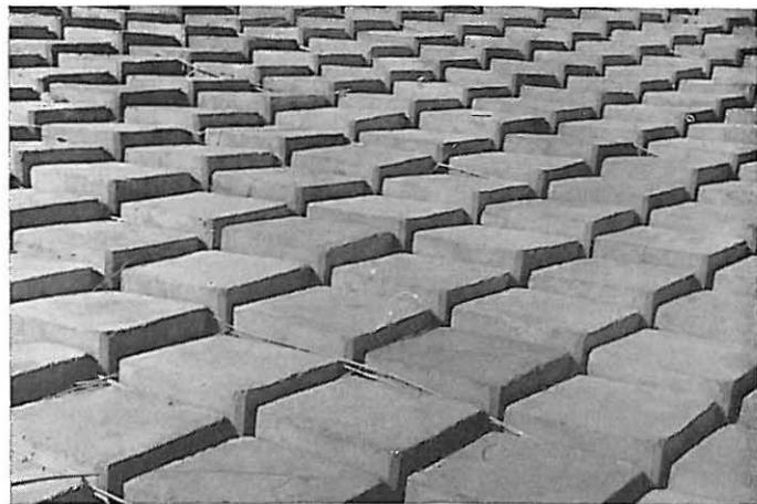
Bild 4 Deckwerksteine von Dyckerhoff & Widmann
