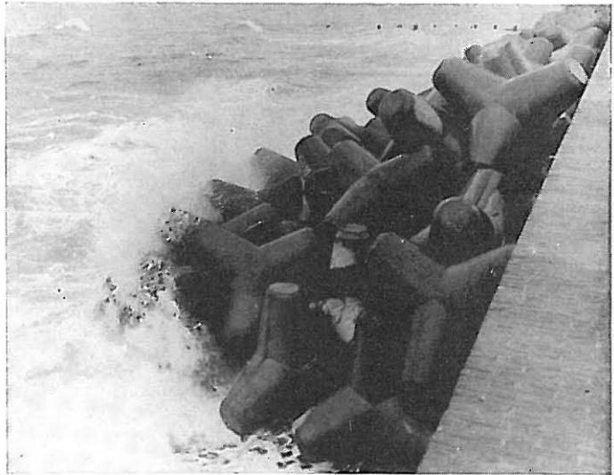
Bild 6 Tetrapoden vor einer gefährdeten Schutzmauer
