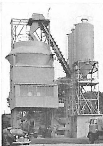
Bild 3 „Dosierturm“ eines Transportbetonwerkes in Gelsenkirchen mit außerhalb angeordneten Zementsilos. Werkfoto: IBAG, Neustadt/Weinstraße
