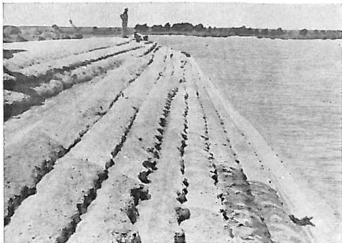
Bild 3 Aussehen der 10 Jahre alten Boden-Zementverfestigung beim Bonny Dam
