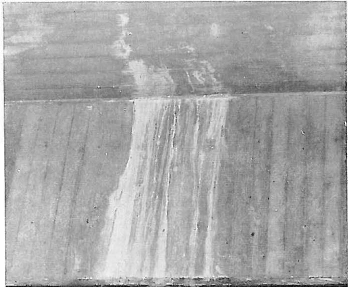
Bild 18 Mörtelverschmutzung an einer Brücke
