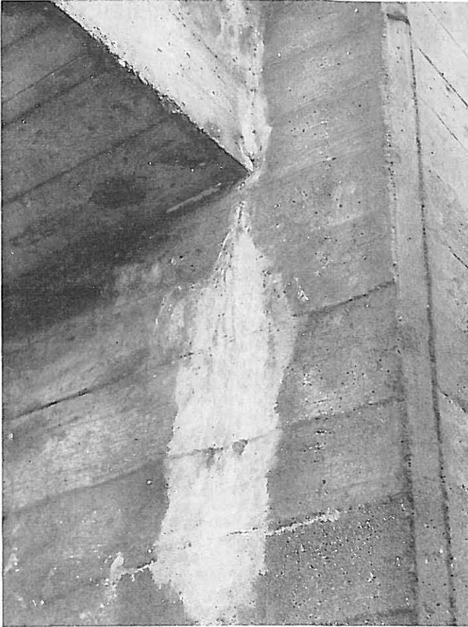
Bild 1 Widerlager einer Brücke mit Kalksinter
