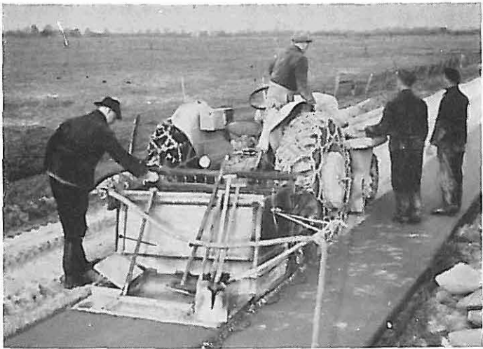
Bild 7 Auf einem Wirtschaftsweg in Norddeutschland wird Flugsand mit Zement verfestigt. Das Mischgerät arbeitet in 3 Längsstreifen von je 1,20 m Breite. Zwischen den Vorder- und Hinterrädern des Traktors ist ein Zementverteiler, hinten angebaut ein Mischkasten mit der Mischwelle. Wasser wird über eine Schlauchleitung zugeführt und durch ein Sprührohr eingespritzt. Nach dem Mischgerät folgt noch ein Verdichtungsgerät. Mit 12 Arbeitern und diesen zwei Geräten können am Tag 600 m Wirtschaftsweg von 3½ m Breite gebaut werden
