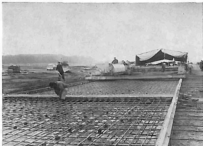
Bild 9 Die Spannbetondecke am Flugplatz Köln-Wahn wird in Längsstreifen gebaut, links vorne die Hüllrohre, in denen die Spannstähle liegen
