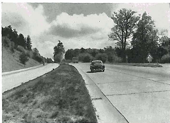
Bild 1 Autobahn Augsburg—Stuttgart, die vor dem Kriege gebaut wurde. Strecken, die auf gutem Untergrund liegen, unterscheiden sich äußerlich heute nur wenig von den Autobahnen der letzten Zeit
