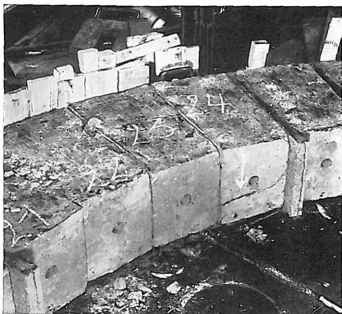
Bild 20 Riß in einem Formstein unter einer auf den halben Ringumfang aufgebrauchten Last von 230 t. (Die 3 in Bild 19 angegebenen Linex-Zwischenlagen waren bei diesem Versuch herausgenommen)
