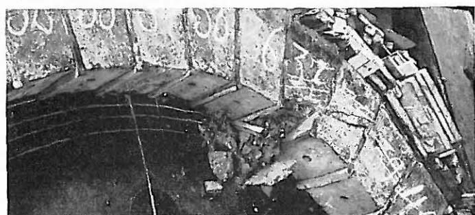
Bild 28 Einzelheiten des Bruchas der Formsteine.
