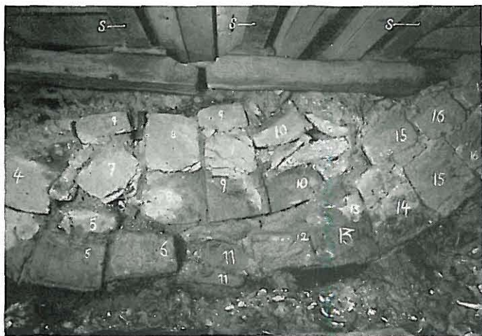
Bild 30 Sohlenbogen einer Strecke aus Betonformsteinen (Campine). Oben erkennt man die Füße S der Schienen. Die Formsteine 7, 8, 9 und 10 sind durch einen von unten nach oben gerichteten Druck hineingepreßt worden. Diese Verformung des Ausbaus wurde durch das Zerquetschen der zusammendrückbaren Fugeneinlagen möglich
