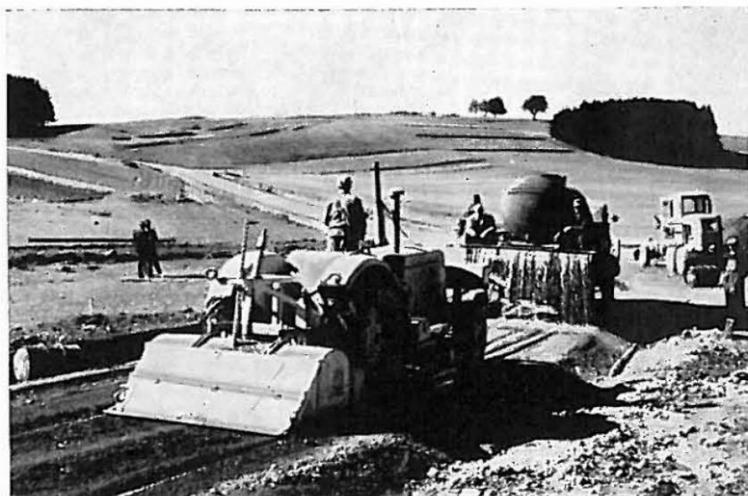
Bild 12 Das Mischgerät fährt knapp hinter dem Wasserwagen, um zu verhindern, daß das Wasser unmittelbar nach der Beigabe in den Fahrspuren zusammenfließt
