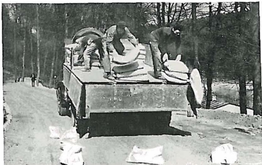
Bild 16 Abwerfen der Zementsäcke auf die vorher gekennzeichneten Stellen
