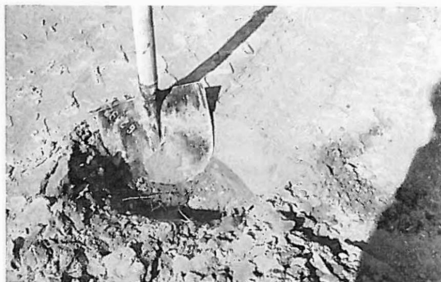
Bild 15 Überprüfen der Schüttdicke des aufgetragenen Fremdmaterials mit Hilfe eines Probeloches
