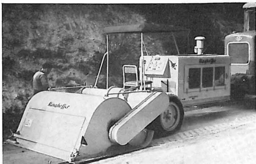
Bild 3 Ringhoffer-Maschine, ein Anhänger-Mehrgangmischer
