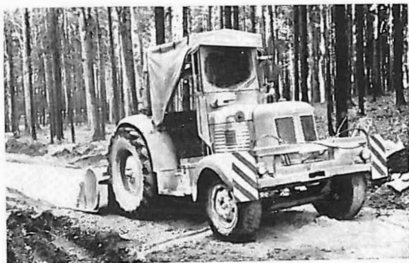
Bild 18 Verteilen des Zements mit der Haube des Mischgerätes auf die volle Breite. (Das Planum muß hierbei sehr eben sein, um eine gleichmäßig dicke Schicht zu erhalten)
