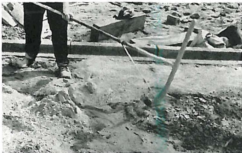
Bild 19 Knollen feuchten Zements. (Liegt der Zement länger am feuchten Boden, dann saugt er Wasser auf und bildet Knollen, die mit dem Schaber zerschlagen werden müssen)
