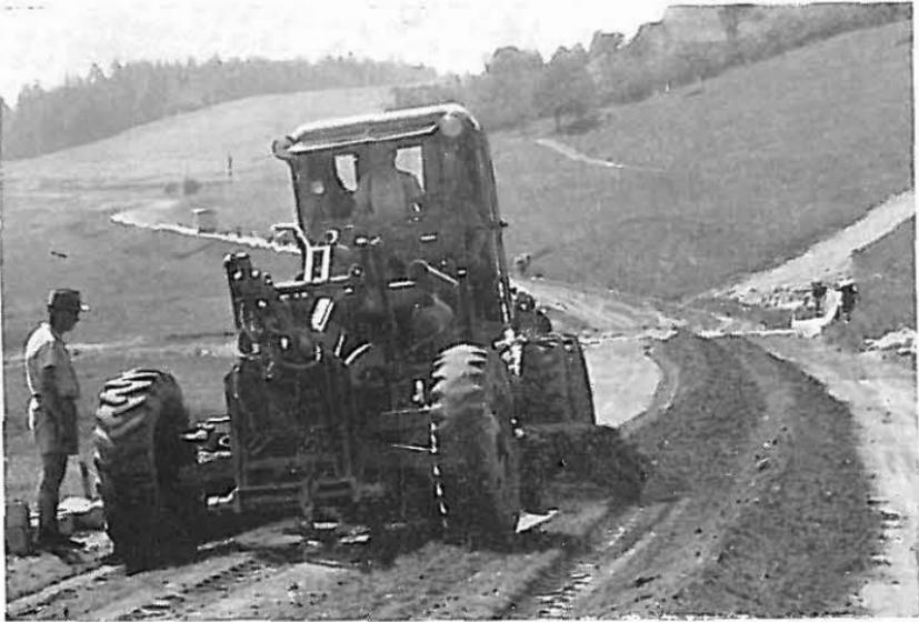
Bild 23 Behelfswises Mischen sandiger Böden mittels Motorgrader. (Der Grader arbeitet dabei nach dem Prinzip eines Freifallmischers)
