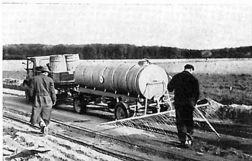
Bild 13 Fahrspuren eines Wasserwagens werden sofort zugeschüttet, um ein Abfließen des Wassers zu verhindern
