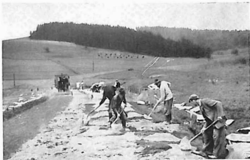
Bild 17 Einmischen des bereits verteilten Zements. (Danoben wird weiter Zement verteilt)
