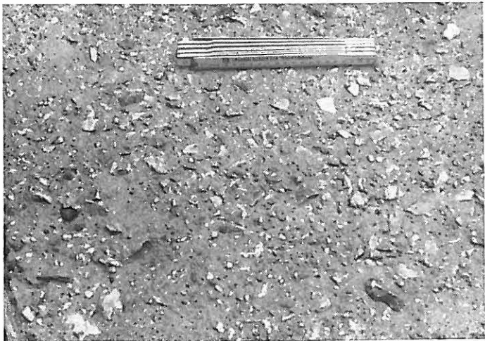
Bild 14 Vorbereitete Arbeitsfuge
