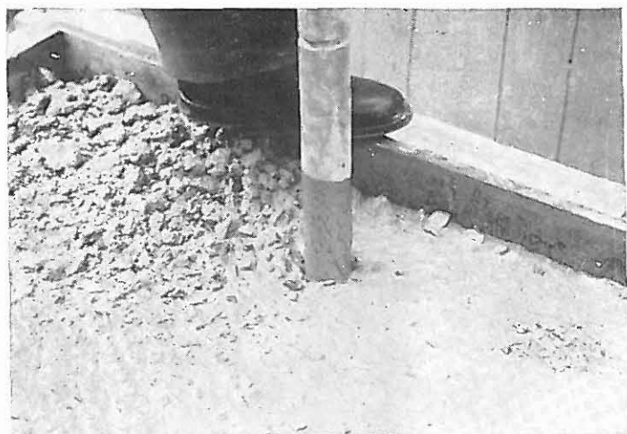
Bild 12 Barytbeton nach Bild 9 beim Verdichten mit dem Innenrüttler
