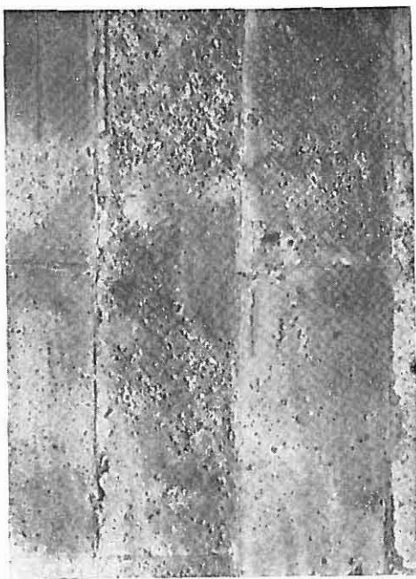
Bild 2 Betondauben aus knapp weichem Beton aus dem unteren Teil eines Silos mit unterschiedlichem Veränderungsgrad
