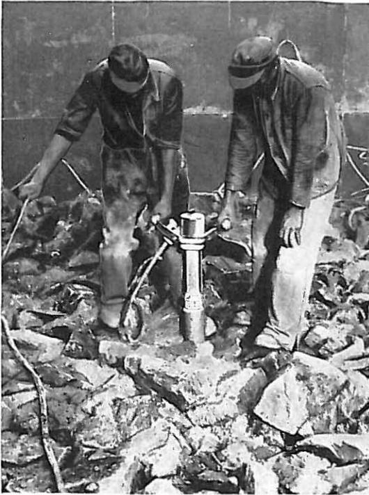
Bild 2 Einrütteln der geschütteten Steineinlagen in Kies-sandbeton (Bettungsbeton)
