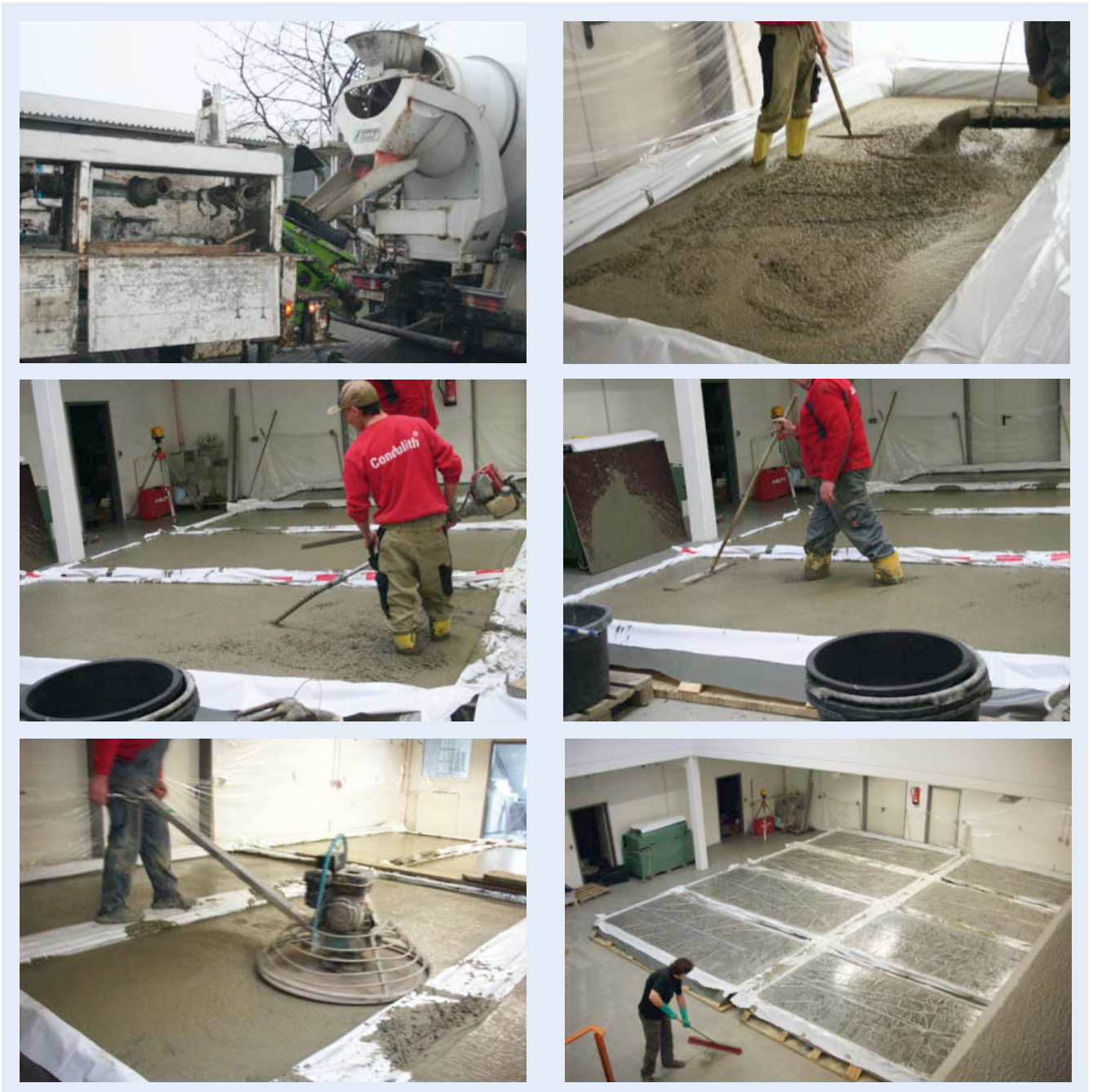
Bild 14: Herstellung der horizontalen Versuchsflächen am 29.02.2012 Figure 14: Production of the horizontal test surfaces on 29/02/2012
