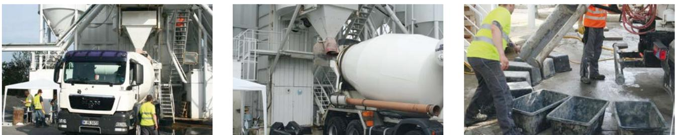
**Bild 2: a) Übersicht über Mischanlage, Fahrmischer und Baustellenlabor; b) Ablassen von Frischbeton nach definierten Mischzeiten in den Fahrmischer; c) Ablassen des Frischbetons aus dem Fahrmischer in Mörtelwannen**
