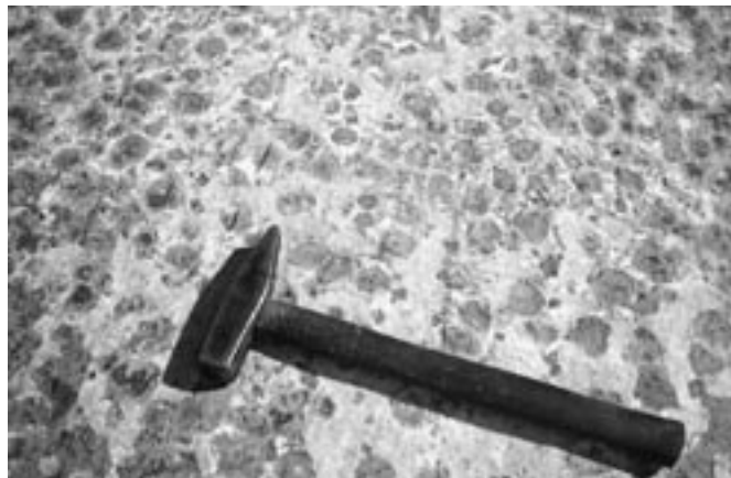
Bild 1: Fleckenförmig korrodierte Mörteloberflächen in zwei Trinkwasserbehältern. Die Beschichtung rechts ist nach rd. 10 Jahren fast vollständig weggelöst.
