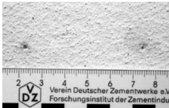
Bild 13: Im Labor erzeugte fleckenförmige Korrosion Figure 13: Brown-spot corrosion produced in the laboratory
