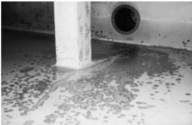
Bild 1: Fleckenförmig korrodierte Mörteloberflächen in zwei Trinkwasserbehältern. Die Beschichtung rechts ist nach rd. 10 Jahren fast vollständig weggelöst.
