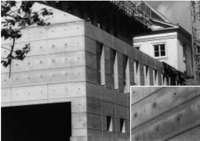
Bild 4: Teil der Fassade des Königlichen Schauspielhauses in Den Haag. Geschößweise hergestellt aus selbstverdichtendem Beton „in einem Guß“; als Detail die Oberfläche mit Ankerlöchern Fig. 4: Part of the façade of the Royal Theatre in the Hague. Built in storeys with self compacting concrete "in one pour". The detail shows the surface with anchor holes. Foto: SPOB
